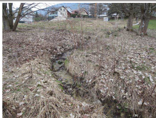
Amont voies CFF
