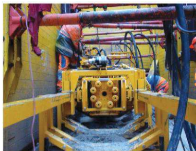
Exemple cellule de poussée pour pousse-tube vériné
